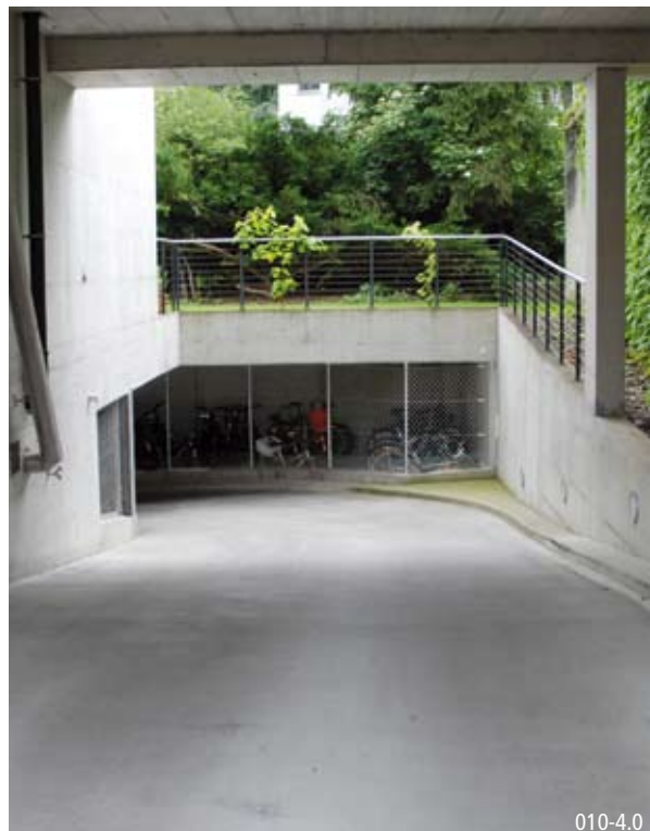
Parcheggio chiuso in garage sotterraneo
