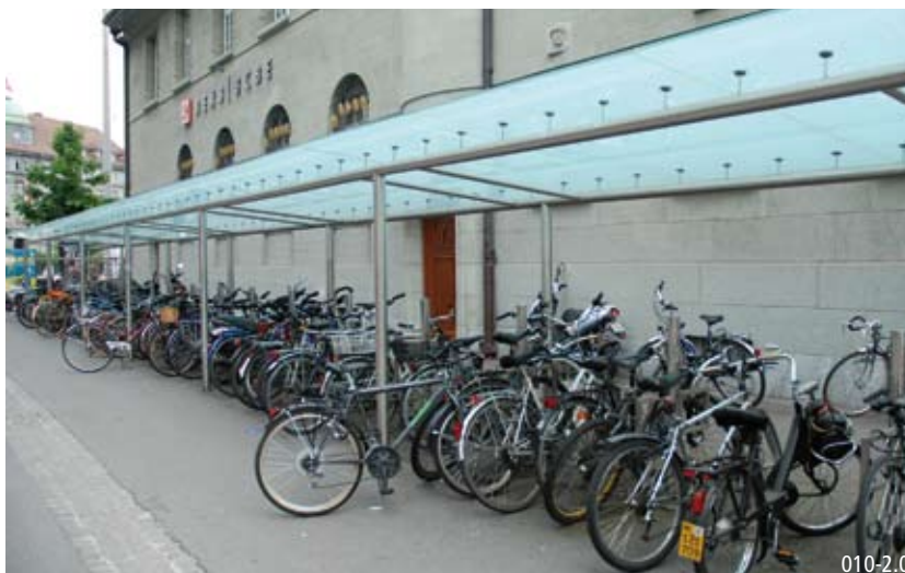
Posteggio per cicli coperto, con possibilità di legare il telaio, ai margini di un'area commerciale
