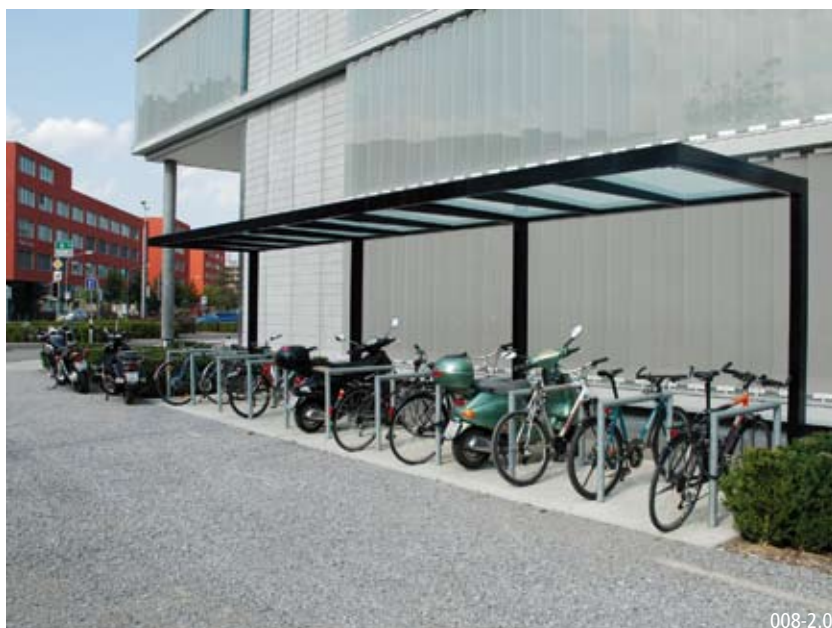
Posti di parcheggio per cicli di collaboratori e visitatori: coperti, ben in vista e a ridosso dell'ingresso
