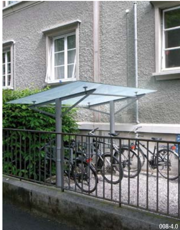
Impianto aperto e coperto, visibile dallo spazio pubblico
